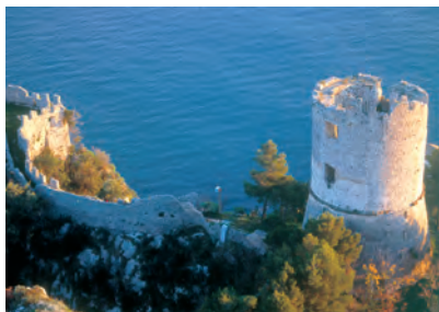
Scala - Torre dello Ziro Scala - Torre dello Ziro
